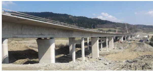
Fig. 5. The viaduct on the I section Lubień-Naprawa (402 m long) [source: 10] Rys. 5. Wiadukt na odcinku I Lubień-Naprawa (402 m długości) [źródło: 10]
