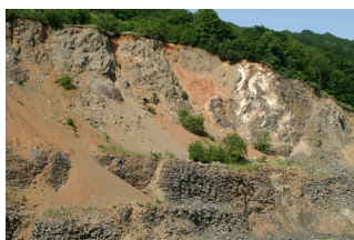
Fig. 11. Malá Veleň, Soutěšsky: abandoned quarry in very poor condition (rock alteration) Rys. 11. Malá Veleň, Soutěšsky: opuszczony kamieniołom w bardzo złym stanie (przeróbka skały)
