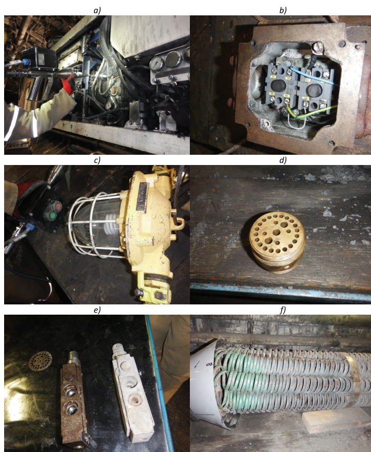
Rys. 9. Czyszczone urządzenia dołowe Fig. 9. Cleaned underground equipment
