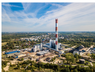
Fot. 4. Elektrociepłownia Zabrze z kotłem wielopaliwowym. Źródło: [15] Photo. 4. Zabrze Heat and Power Plant with a multi-fuel boiler. Source: [15]
