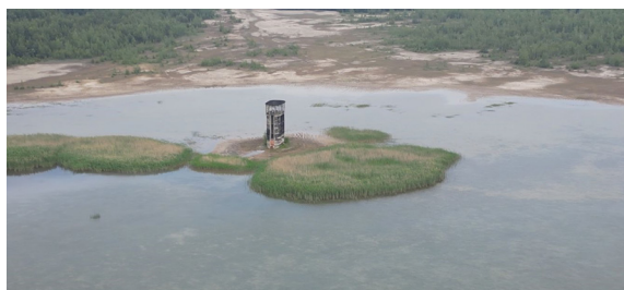
Fig. 6. Photo of the disused overflow tower No. 2 Rys. 6. Zdjęcie nieczynnej wieży przelewowej nr 2
