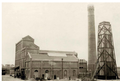
Fot. 3. Spalarnia odpadów w Poznaniu uruchomiona w 1927 r. Źródło: [15] Photo. 3. Waste incineration plant in Poznań launched in 1927. Source: [15]
