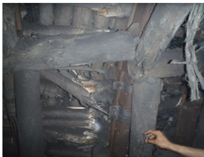
Fig. 2. Some typical failures in deep drifts in Mao Khe coal mine (by authors) Rys. 2. Niektóre typowe awarie w głębokich sztolniach w kopalni Mao Khe (zdjęcia autorów)
