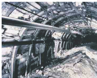
Fig. 1. The collapses of deep underground drift floor at Quang Ninh coal mine area [1] Rys. 1. Zawalenie się głębokiej podziemnej sztolni w zagłębiu węglowym Quang Ninh [1]
