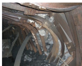
Fig. 4. The failure on right sidewall of deep underground drift at Dong Ri coal mine [1] Rys. 4. Awaria na prawej bocznej ścianie sztolni głębokiej podziemnej kopalni Dong Ri [1]
