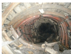
Fig. 3. The collapses of drift floor of deep underground drift at Dong Ri coal mine [1] Rys. 3. Zawalenie się spągu sztolni głębokiej kopalni Dong Ri [1]
