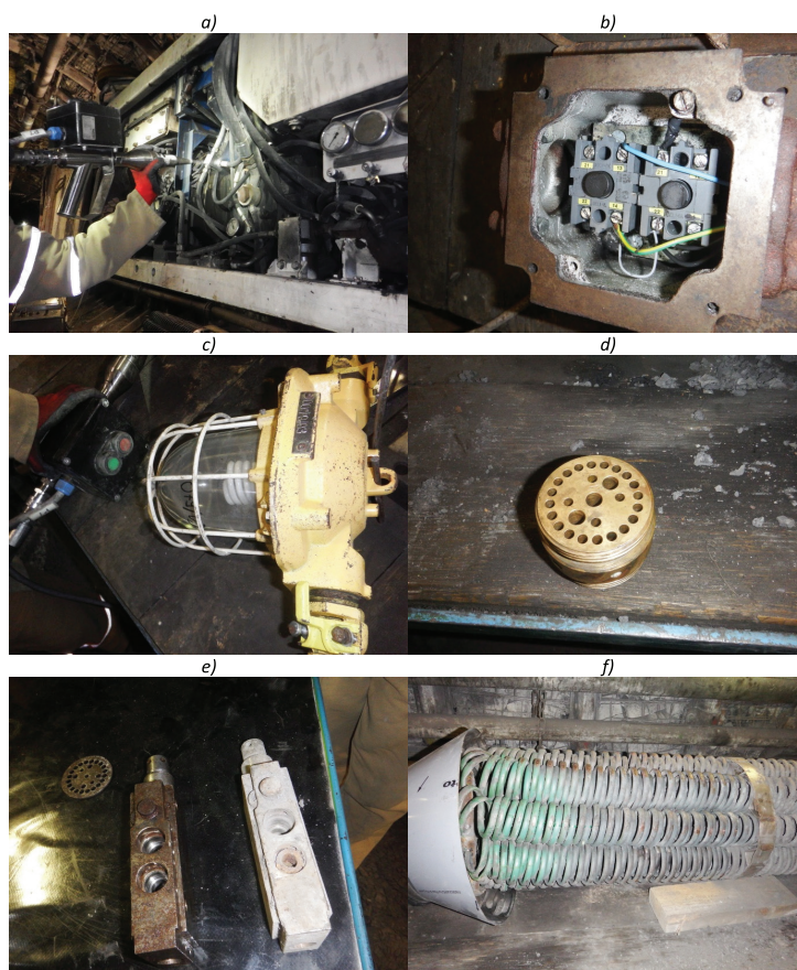
Rys. 9. Czyszczone urządzenia dołowe Fig. 9. Cleaned underground equipment
