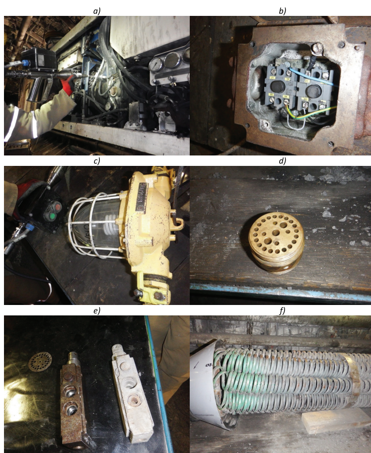
Rys. 9. Czyszczone urządzenia dołowe Fig. 9. Cleaned underground equipment
