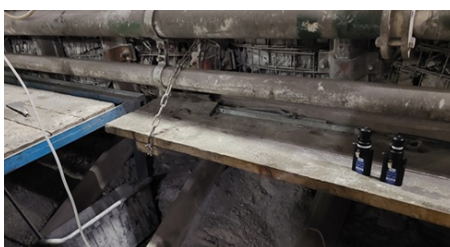
Rys. 8. Pyłomierze CIP-10 – chodnik taśmowy 2fN w LW Bogdanka [10] Fig. 8. CIP-10 dust meters – 2fN belt gallery at LW Bogdanka [10]
