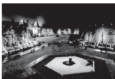
Fig. 3. Saline graduation tower and fountain in Inowrocław [21] Rys. 3. Tężnia i fontanna solankowa w Inowrocławiu [21]
